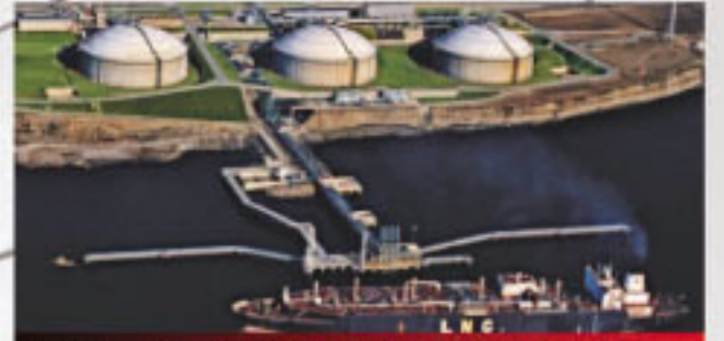
Botaş Lng Terminali Adp ve Mcc Panelleri Değişimi Projesi
