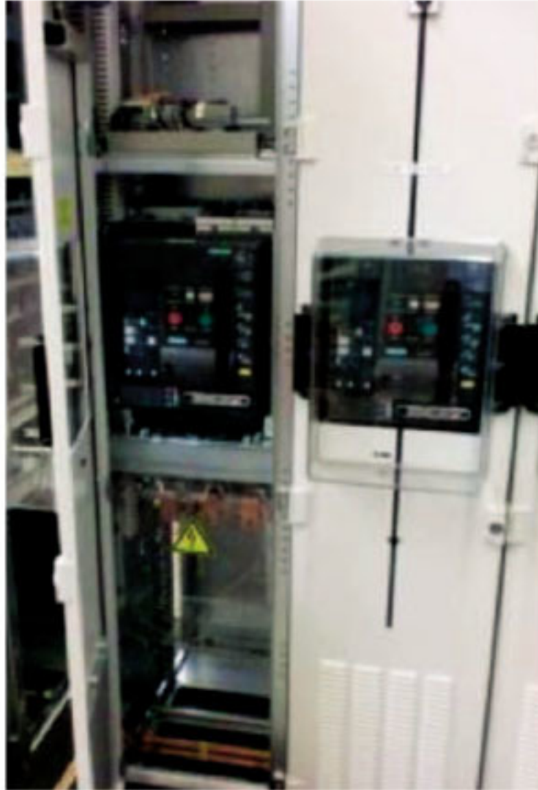
Form 3a Harici iletkenler ile anabara arasında bölmelendirme yok
