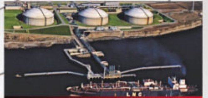
Botaş Lng Terminali Adp ve Mcc Panelleri Deęiřimi Projesi
