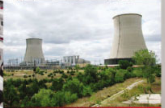
Hamitabat Termik Santrali Soğutma Kuleleri Çekmeceli Mcc Panelleri
