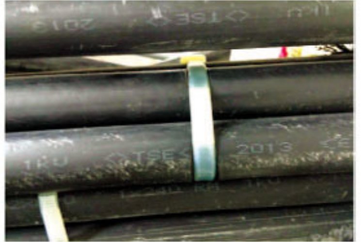
Resim 2: Kablolarda deformasyonlar
